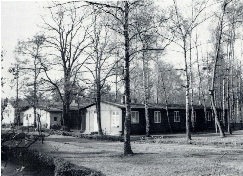
Ehemalige Unterakunftsbaracken des Staumühlenlagers, erbaut 1915. Aufnahme April 1990.
