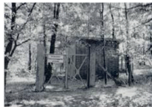
Die Wasserversorgungsanlage für das Staumühlenerlager. Aufnahme Mai 1936.
